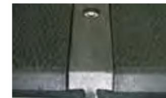
Montage mit Verbindungsprofil
